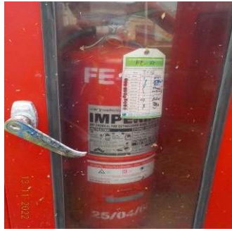
รูปที่ 3-9 การตรวจเช็คอุปกรณ์ดับเพลิงแบบมือถือ บริเวณหน้าท่าเทียบเรือ
