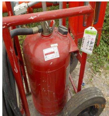
รูปที่ 3-10 การตรวจเช็คอุปกรณ์ดับเพลิงแบบติดล้อ บริเวณหน้าท่าเทียบเรือ
